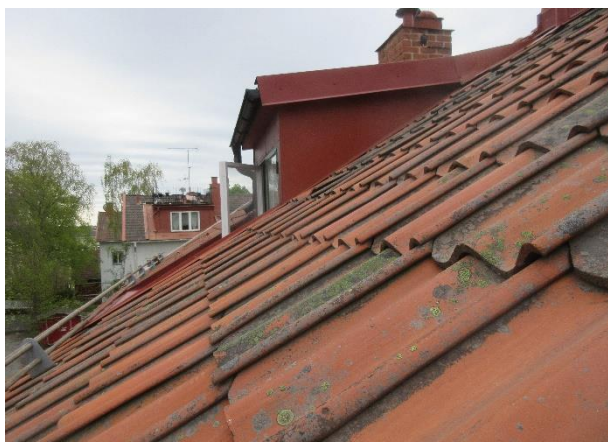
Yttertaket belagt med lertegel
