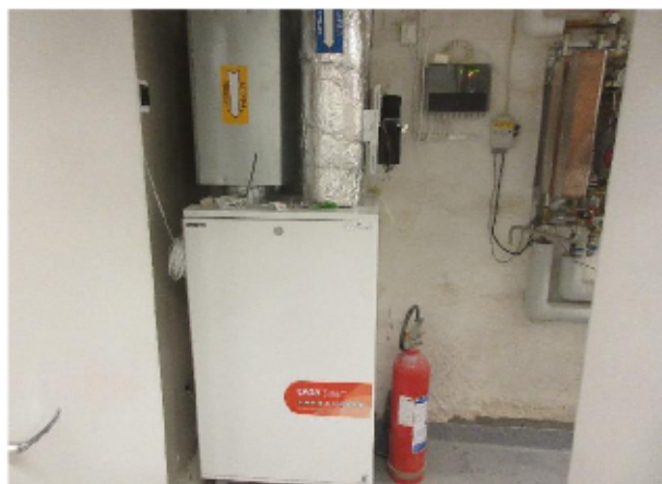
Ventilationsaggregatet för källarplan
