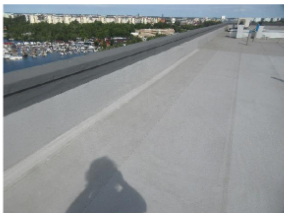
Yttertak på höga delen som lagats.
