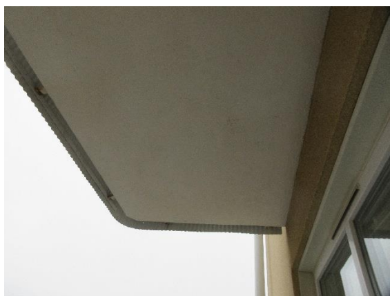
Undersida av balkongplatta
