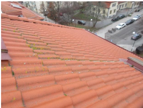
Yttertak renoverat med nya pannor
