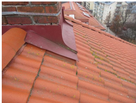
Yttertakens plåtbeslagning moderniserad
