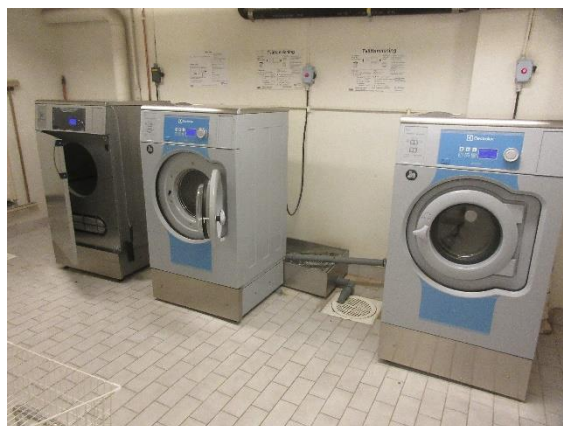
Tvättstugan i källaren
