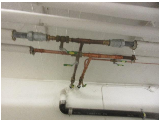
Delvis gamla galvaniserade kallvattenrör
